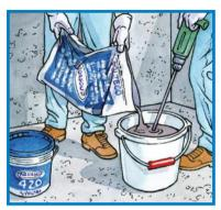
Agitare il componente liquido di AQUASCUD® nel suo contenitore e successivamente versarlo in un secchio. Aggiungere gradualmente sotto agitazione il componente polvere di AQUASCUD®; effettuare la miscelazione per 3÷5 minuti utilizzando un trapano con frusta fino all'ottenimento di un impasto omogeneo e privo di grumi.
