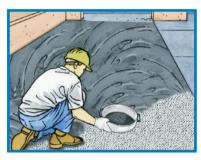
Il prodotto è rifinibile con AQUASCUD® 500 oppure con ceramica. La posa della ceramica, da effettuarsi dopo 16 ore, deve essere eseguita a fuga larga con adesivi di tipo C2 (preferibilmente con classe di deformabilità S1 e S2). La stuccatura va eseguita con malte cementizie sigillanti di classe CG2. La finitura con AQUASCUD® 500 può essere
